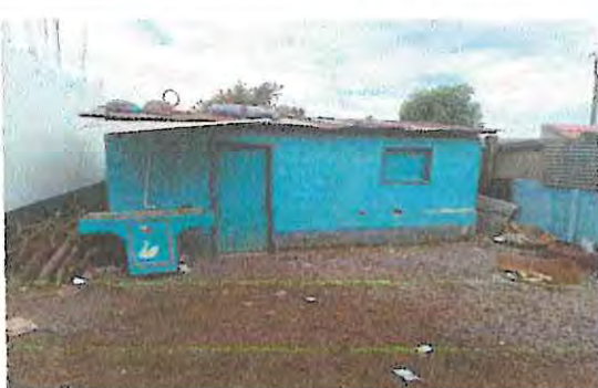
Foto 3: así luce el techo. Puertas y ventanas actualmente
